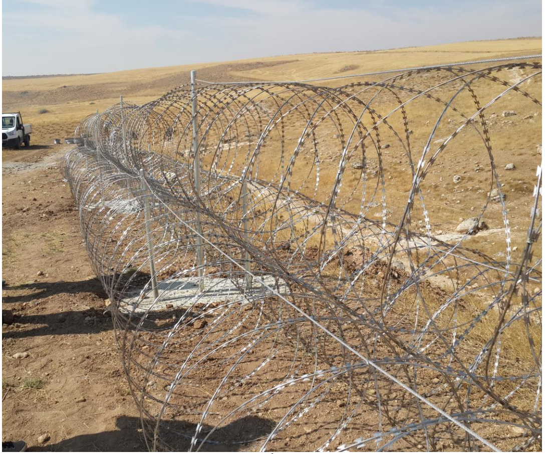
Batı Cephesi Helezonik Jiletli Tel Yapım İŖi
