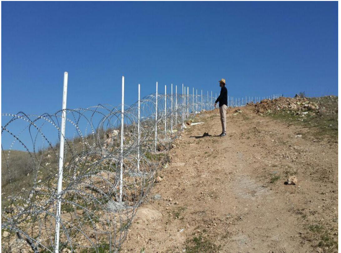
Batı Cephesi Helezonik Jiletli Tel Yapım İŖi
